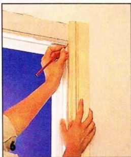
Нанести размеры нового наличника нужно очень тщательно.
