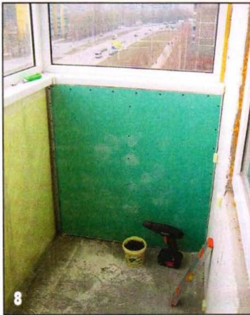
8 Обшивка парапета гипсокартоном.
