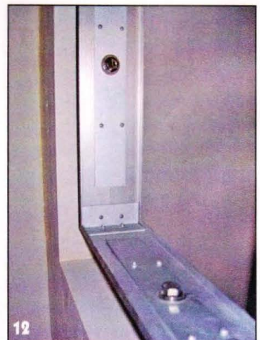
11 Для закрепления рамы предусмотрел четыре опоры: по одной – снизу и сверху, а две – сбоку. Раму крепил на шпильках гайками. Верхнюю опору установил после монтажа рамы.
