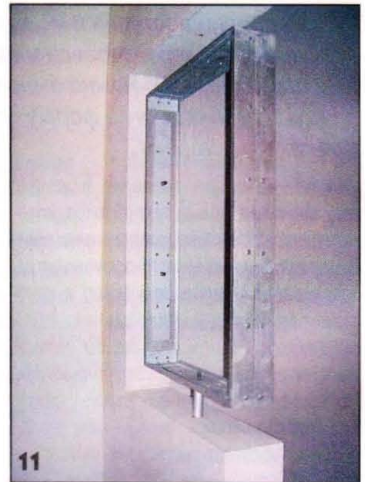
11 Для закрепления рамы предусмотрел четыре опоры: по одной – снизу и сверху, а две – сбоку. Раму крепил на шпильках гайками. Верхнюю опору установил после монтажа рамы.
