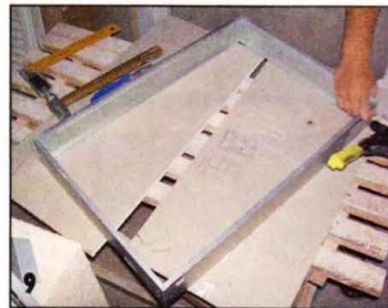
9 Рама получилась достаточно прочной, чтобы выдержать вес стеклоблоков.
