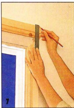
Нанести размеры нового наличника нужно очень тщательно.
