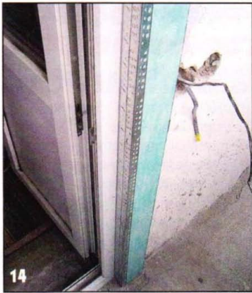
14 Утеплитель и прилегающую часть стены покрыл толстым слоем шпательки и приклеил на неё элементы наличника.
