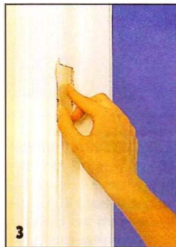
Уменьшение глубины гнезда петли.
