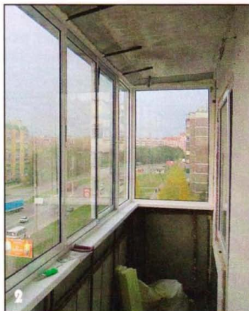
2 Установку нового остекления доверил специалистам — монтажникам фирмы-производителя.
