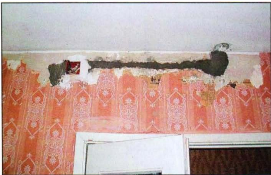
Один из вариантов монтажа отсутствующей проводки: от распаечной коробки по стене (в штробе) — до места, где проводка будет переходить на потолок, а затем — по полостям в плитах перекрытия.
