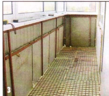
3 На пол уложил экструдированный пенополистирол в два слоя (толщина слоёв 100 и 70 мм). Для армирования стяжки поверх пенополистирола положил металлическую сетку.
