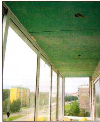
9 Потолок, как и парапет, тоже обшит гипсокартоном.
