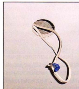
Если провода заранее проложены за гипсокартонной обшивкой, то в потолочном листе нужно просверлить отверстие и аккуратно вытянуть их наружу.
