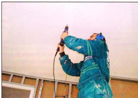
Если провода заранее проложены за гипсокартонной обшивкой, то в потолочном листе нужно просверлить отверстие и аккуратно вытянуть их наружу.
