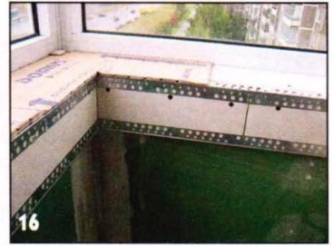
16 Пластмассовый подоконник над парапетом расширил под размер мозаики.
