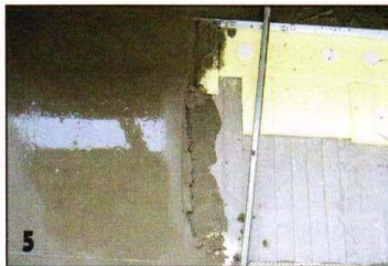
Укладка основной стяжки по маякам. Чтобы сократить расход раствора, по краю лоджии дополнительно положил куски пенополистирола.
