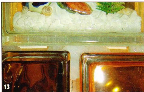
Поскольку силикон твердеет со скоростью 2 мм/сутки, каждый ряд блоков нужно временно фиксировать, чтобы герметик не выдавливался стеклоблоками. Для этого в швы вставлял деревянные клинчики. А чтобы удержать блоки от смещения по отношению к раме, использовал временные технологические накладки из гипсокартона.
